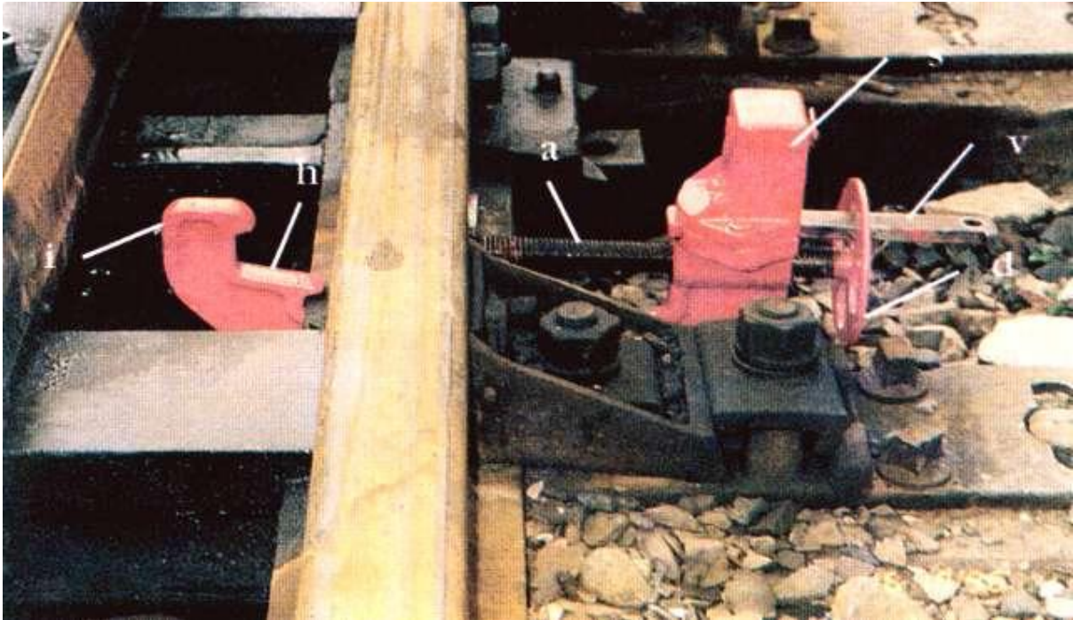
Rys. 1 Zabezpieczenie iglicy odsuniętej Hak h obejmuje stopkę szyny, występek p i przeszkadza przesunięciu się iglicy do opornicy
