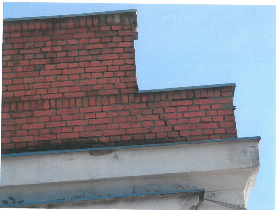
Fot. XV. Korozja tynku na gzymsie żelbetowym i ścianie poniżej gzymsu
