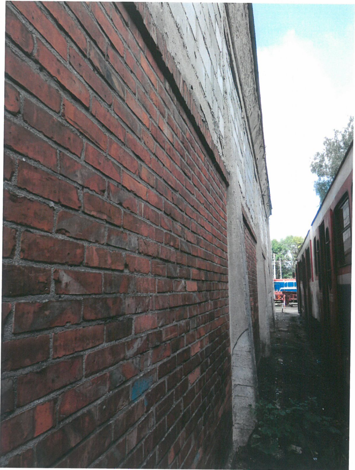
Fot. VI. Elewacja wschodnia – fragment
