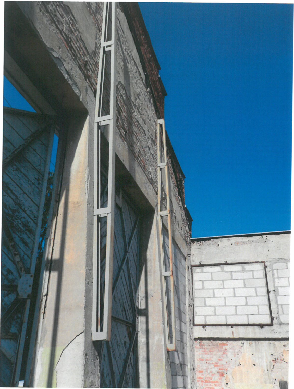
Fot. VIII. Prowizoryczne wzmocnienia stalowe ściany frontowej
