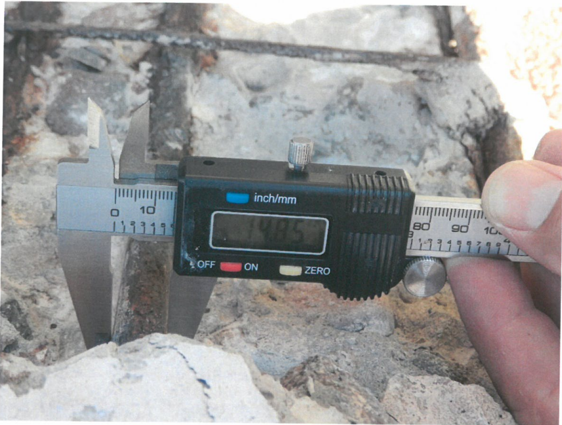
Fot. XXI. Korozja tynku i zbrojenia żelbetowego gzymsu od strony wewnętrznej – ściana zachodnia, część północna
