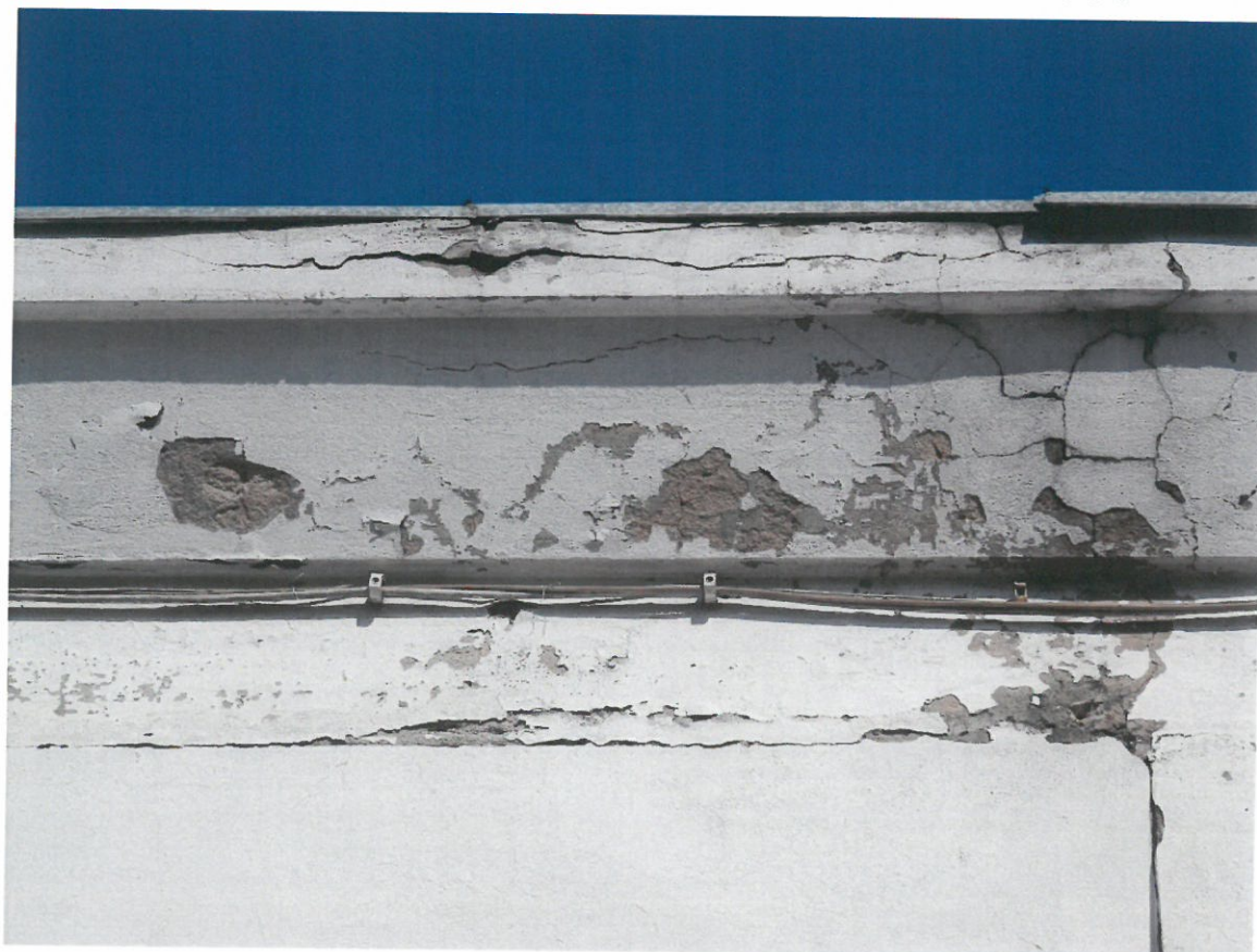
Fot. XV. Korozja tynku na gzymsie żelbetowym i ścianie poniżej gzymsu
