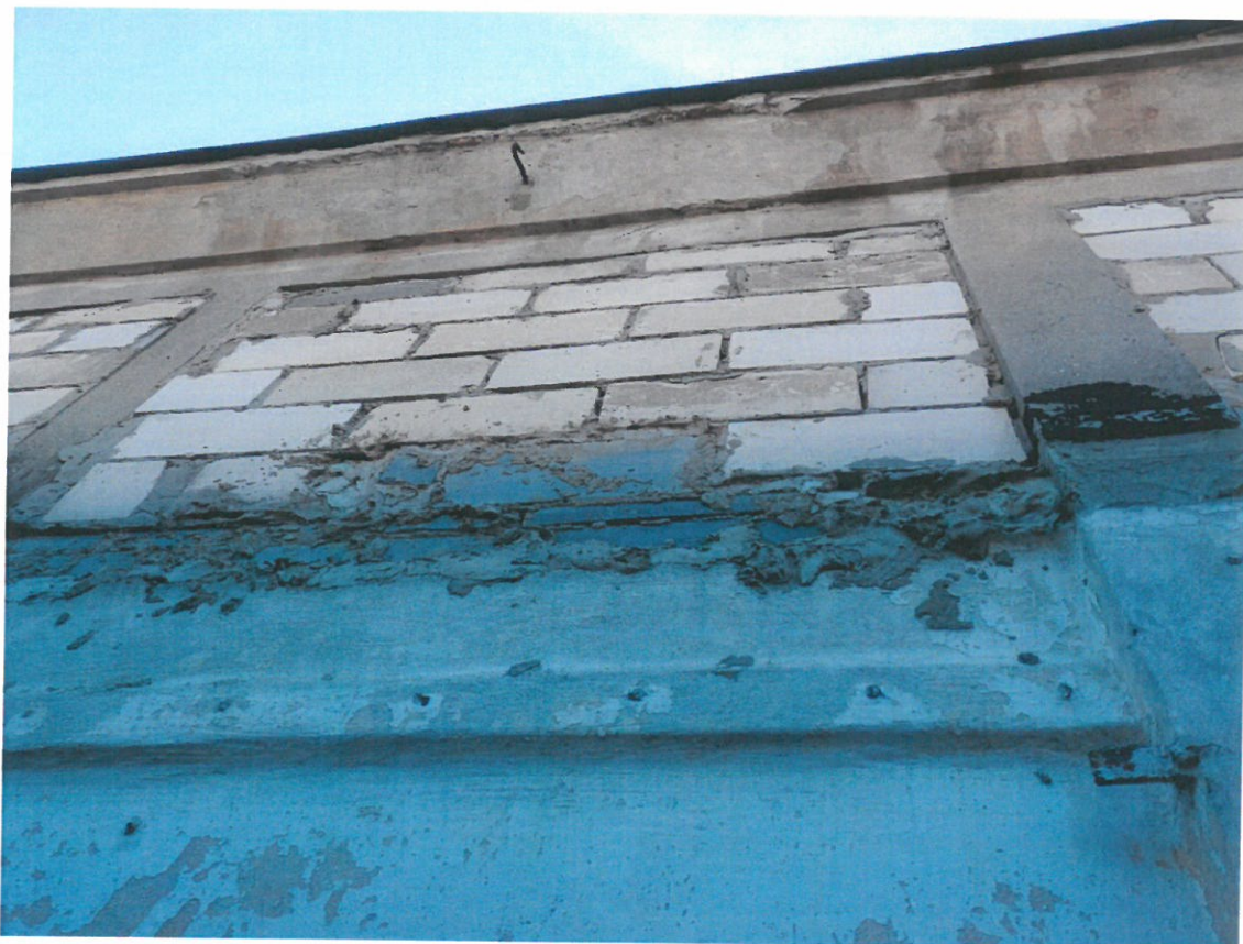
Fot. XVII. Zamurowanie okien siporeksem – ściana wschodnia
