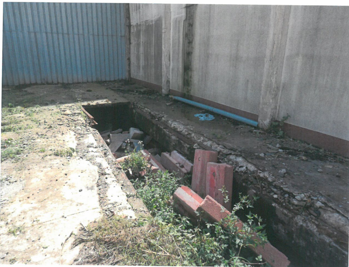
Fot. IX. Częściowo odkryty kanał naprawczy w narożniku południowo-zachodnim
