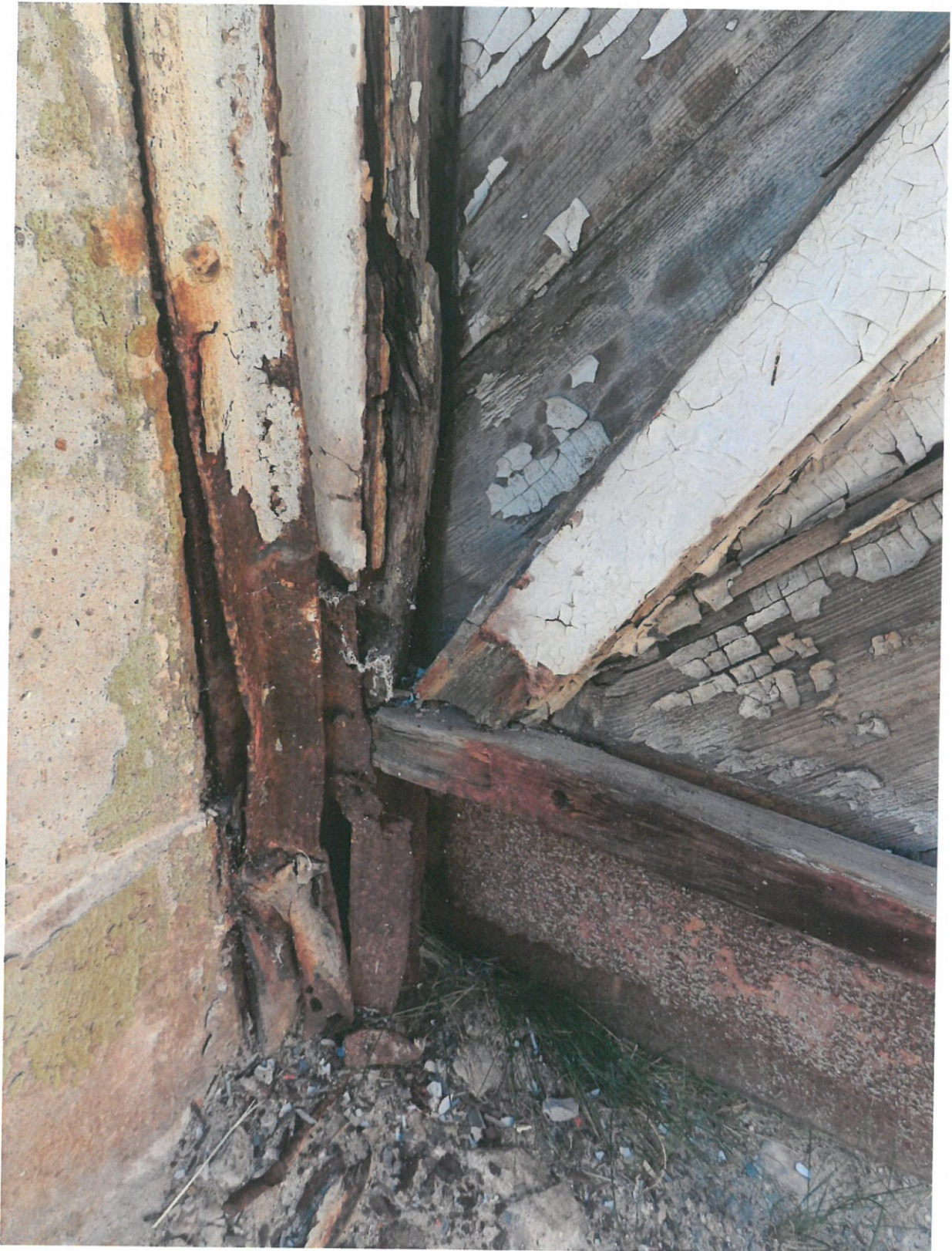
Fot. XI. Korozja wrót drewniano stalowych w dolnej części – szczegół
