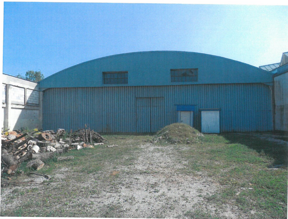
Fot. VII. Ściana szczytowa części czynnej starej Elektrowozowni
