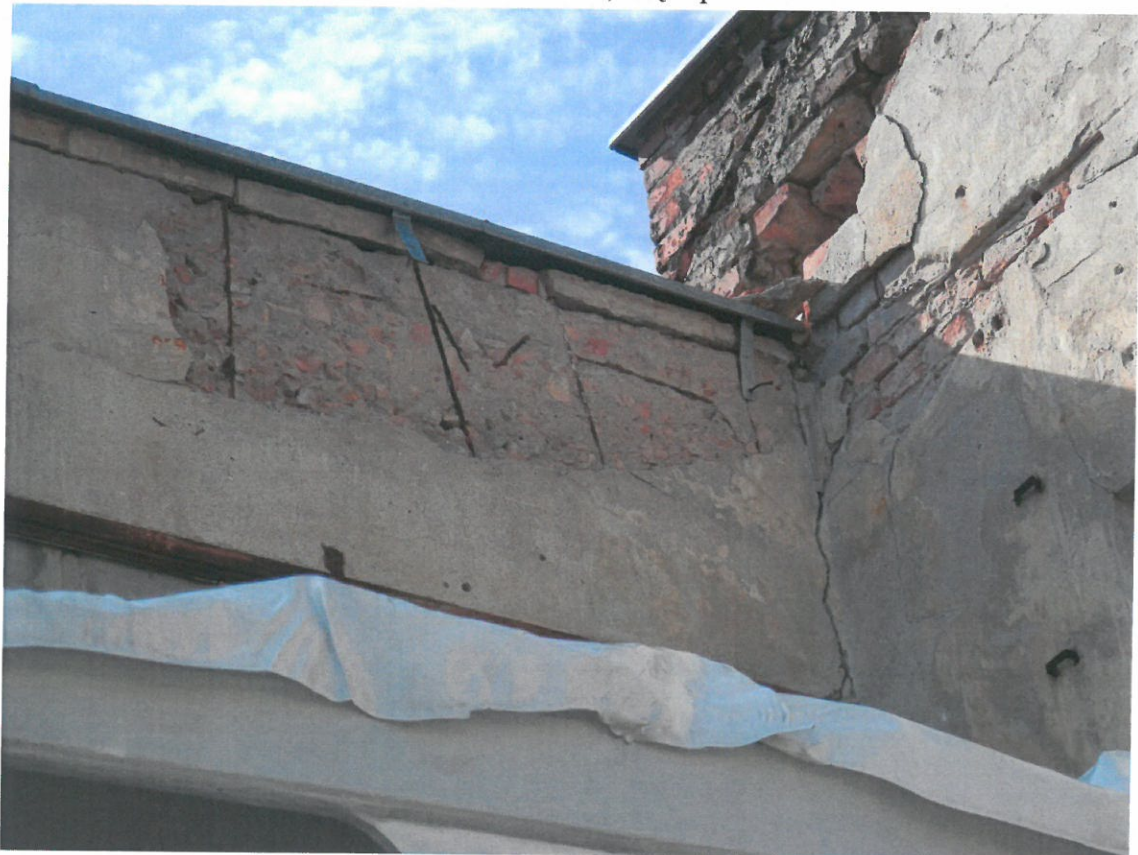
Fot. XXI. Korozja tynku i zbrojenia żelbetowego gzymsu od strony wewnętrznej – ściana zachodnia, część północna
