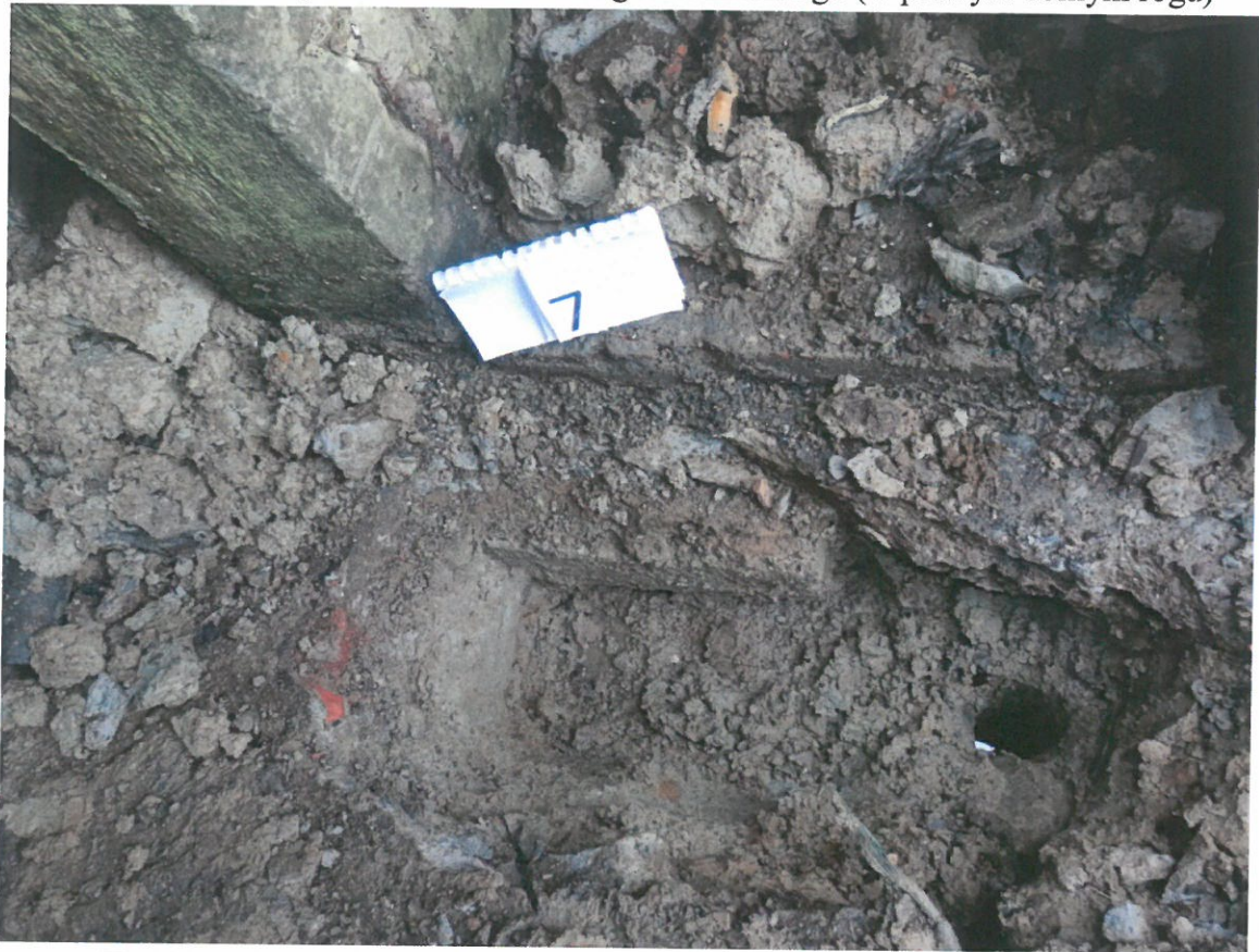
Fot. 8. Odkrywka fundamentowa nr III. Widoczny zarys stopy żelbetowej.
