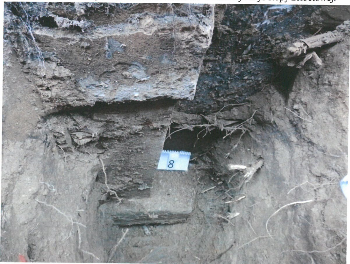
Fot. 8. Odkrywka fundamentowa nr III. Widoczny zarys stopy żelbetowej.
