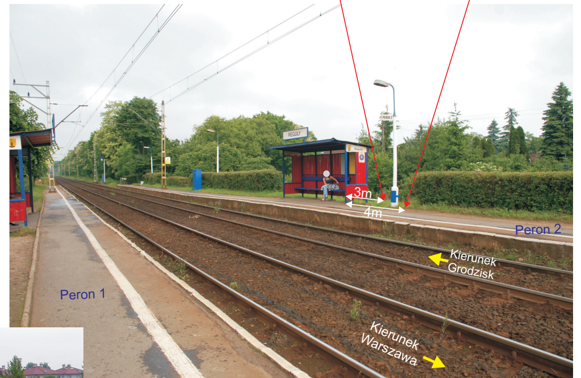
Szafa teletechniczna projektowana
